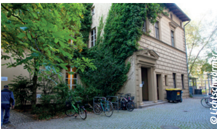
Eingangsbereich vom Ballhaus
