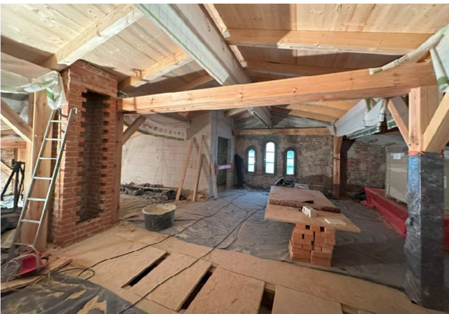
Das Pestalozzi-Fröbel-Haus in der Sanierung
