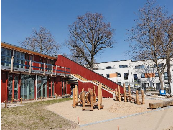
© Bianka Gericke | Baustelle der Kita im März 2024
