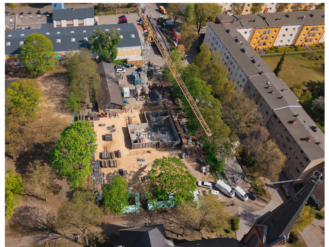
Baustelle an der Auguste-Viktoria-Allee Bild: Th. Drechsler / B. Gericke
