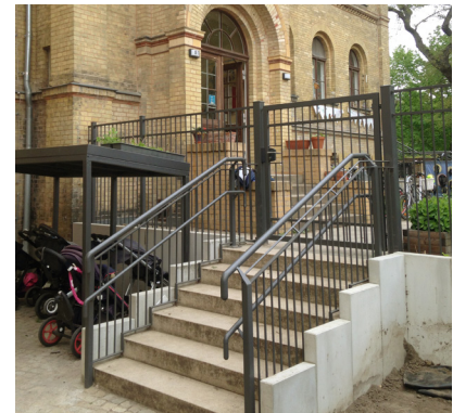
saniertter Zugang Kinderhaus
