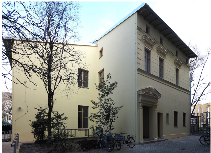
Gebäudeeingang mit rückwertiger Fassade
