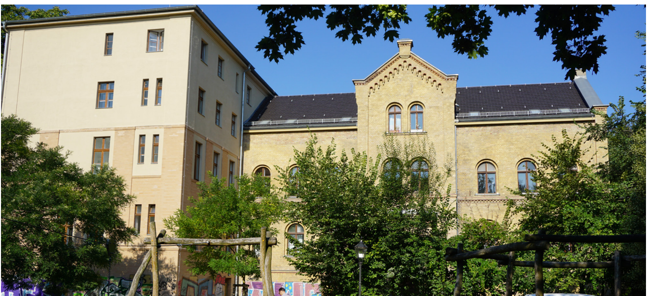
Fassade „Vorderhaus“ und „Kinderhaus“
