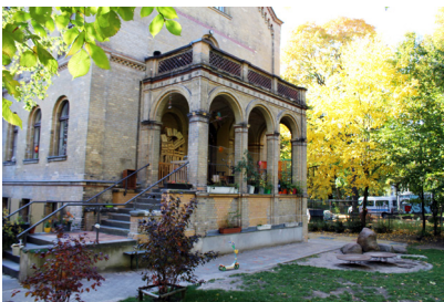
Vorgarten und Fassade „Kinderhaus“
