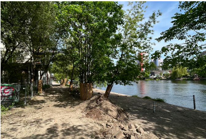
Spreeuferweg im Bau
