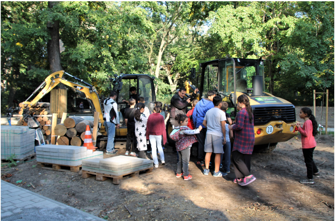
Baustellenbeteiligung Waldemarstraße 57 © STATTBAU
