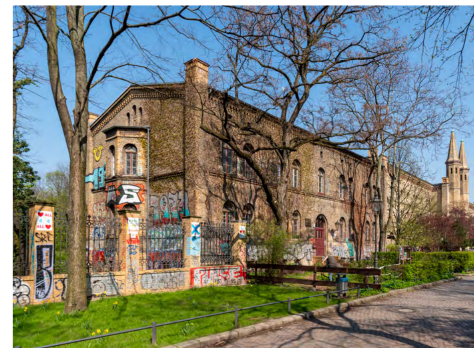
Mariannenplatz 3 vor der Sanierung 2018 © Ouwerkerk
