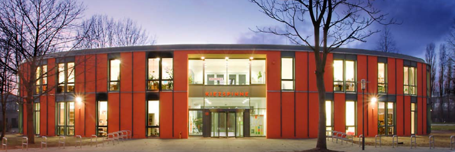
Neubau der Orangerie/ Kiezspinne c 2006 Buddensieg Ockert Architekten
